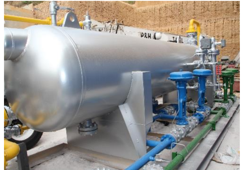
REPARACION SEPARADOR DE GAS
